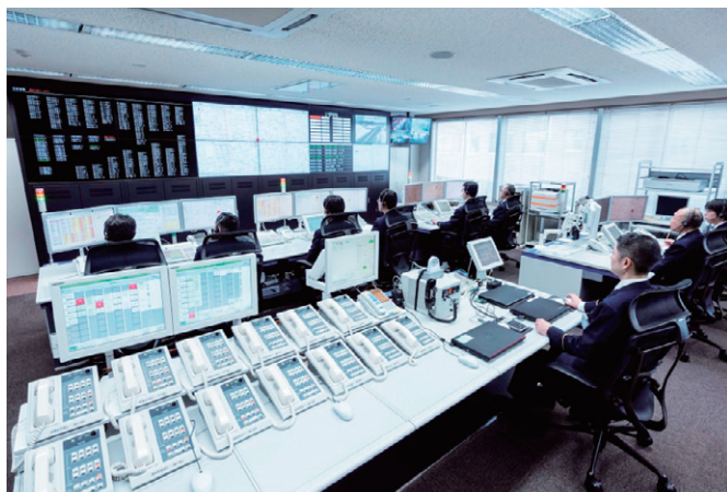
消防指令センター
