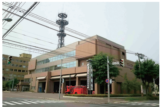
とちか広域消防局庁舎
